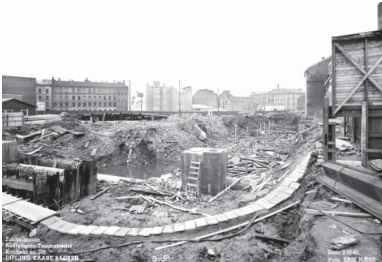
Vaterland ble sanert samtidig som anleggsarbeidet med T-banen tok til i 1960. Bildet er tatt fra krysset Rødfyllgata – Tomtestredet. (Foto: Erik Ness, A-40209/Uea0007/040)
